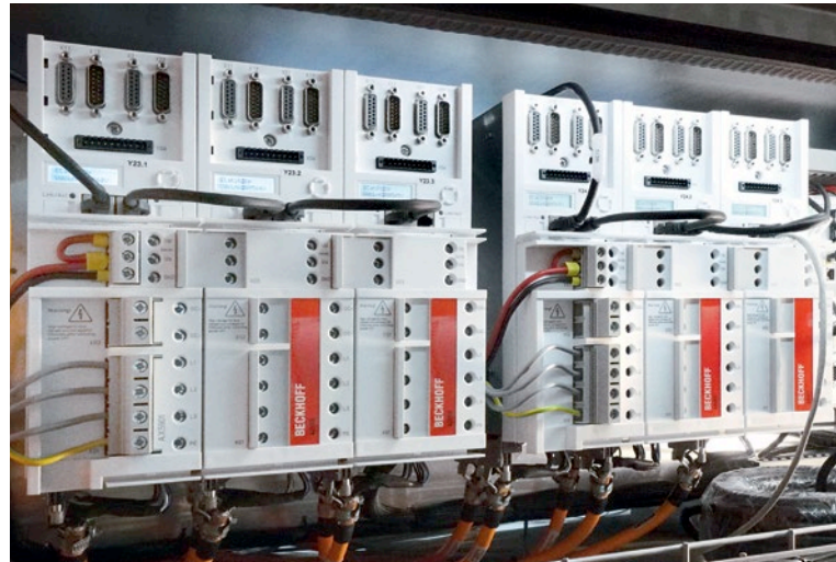
Zur Antriebssteuerung der Schneidroboter nutzt Valka die EtherCAT-Servoverstärker AX5203.
