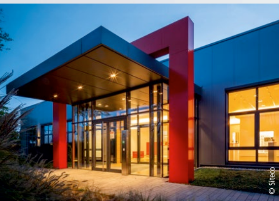
Intelligente Lichtsteuerung in der Beckhoff-Klemmenfertigung
